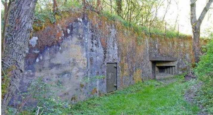
Einer der Bunker bei Eisen. Am Tag des offenen Denkmals gibt es hier von 10 bis 18 Uhr Führungen nach Bedarf. Foto: Peter Waltje
